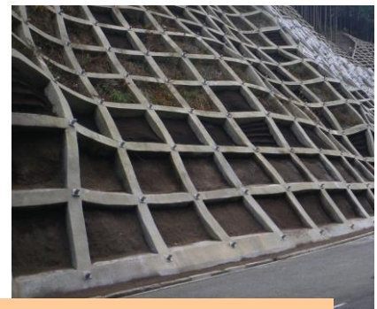
上部BIWAソイル緑化工法 下段BIWAチップマルチング工法 施工完了
